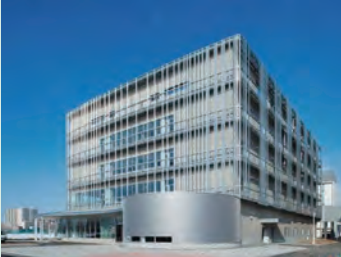
【FMI国際拠点棟】FMI国際拠点のほか、社会・地域創生本部、HSFC（エイチフォース）、HX（エイチクロス）などが置かれている。
