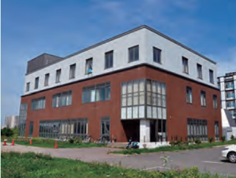
【北キャンパス総合研究棟3号館】産学・地域協働推進機構、スタートアップ創出本部、産学連携推進本部などが置かれている。
