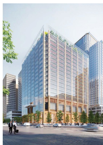
（仮称）東京海上ビルディング新築工事 （S・RC・木構造）
